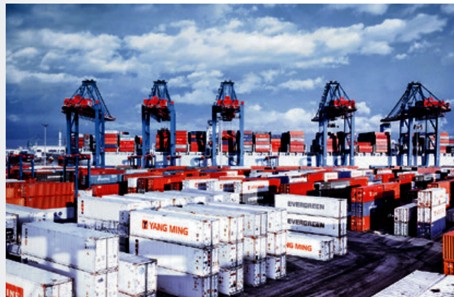
Skladiště kontejnerů na terminálu Tollerort.
