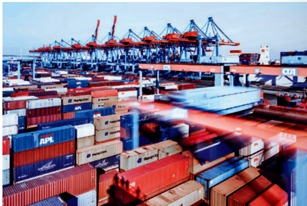
Jeřáby při práci na blokovém skladišti CTA.
